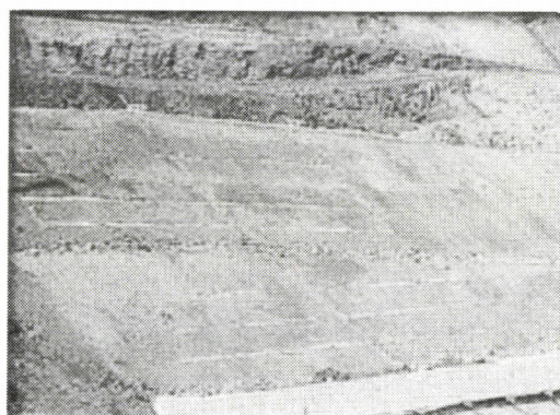
写真-1 盛土排水材の例
