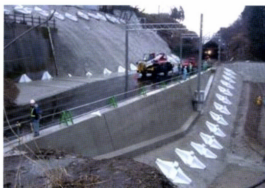
復旧状況 (220k305m 付近)
