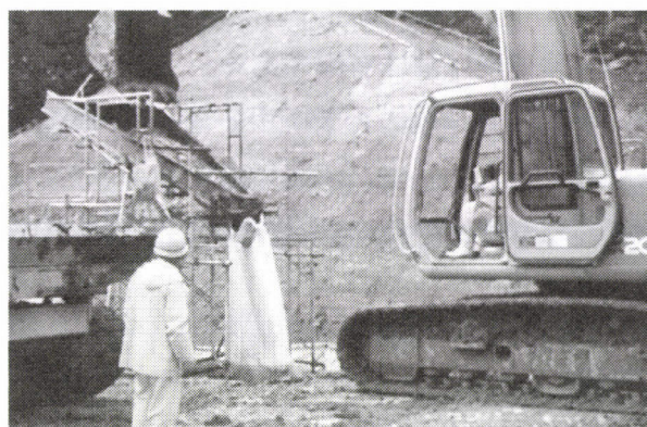
写真-3 充填状況
