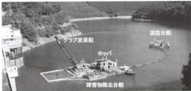
写真-2 施工状況
