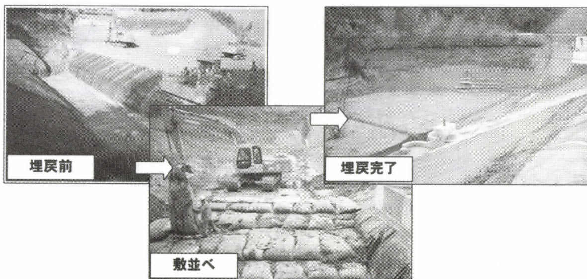
写真-4 施工状況
