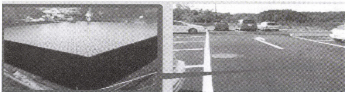
写真-1 駐車場にアクアプラ工法を適用した工事例
