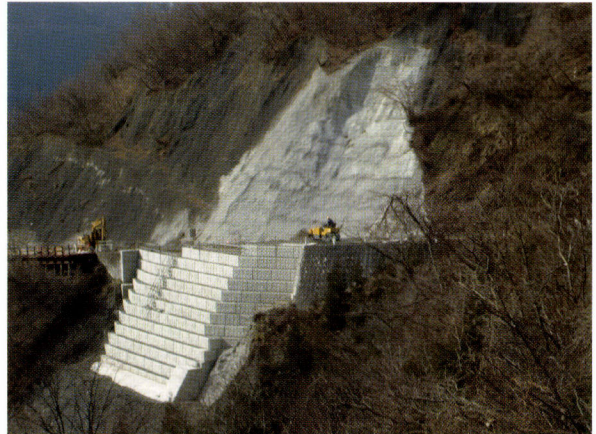
箱型擁壁の施工事例
