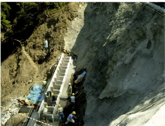
箱型擁壁の組立て状況
