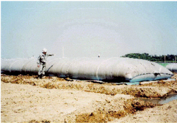
袋詰め脱水処理工法
