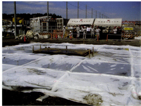
人口軟弱地盤での載荷試験状況
