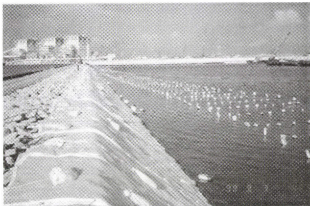
写真-5 保護マット敷設状況
