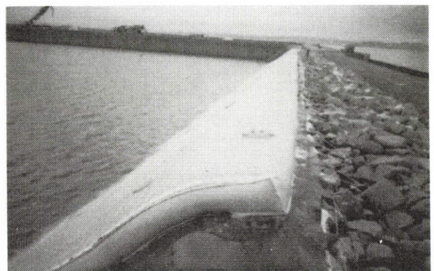
写真-7 布製型枠(遮水シートの保護材として使用)
