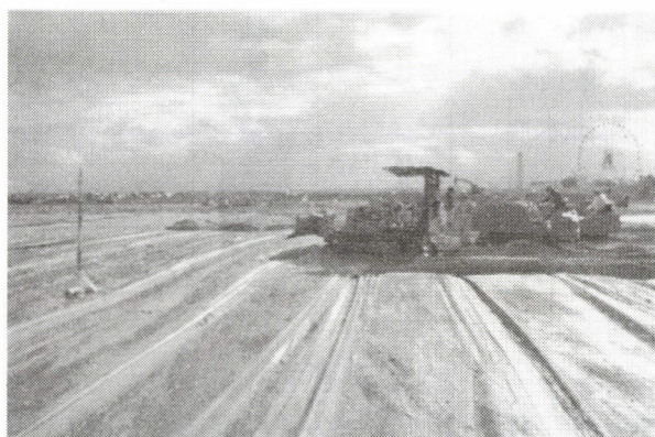
写真-1 ジョグリッドを用いた覆土
