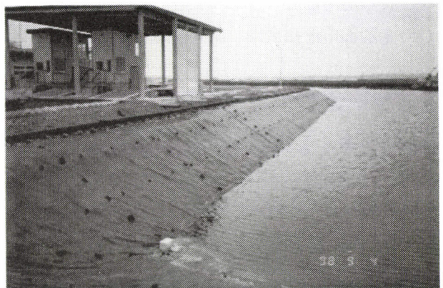
写真-6 遮水シート敷設状況
