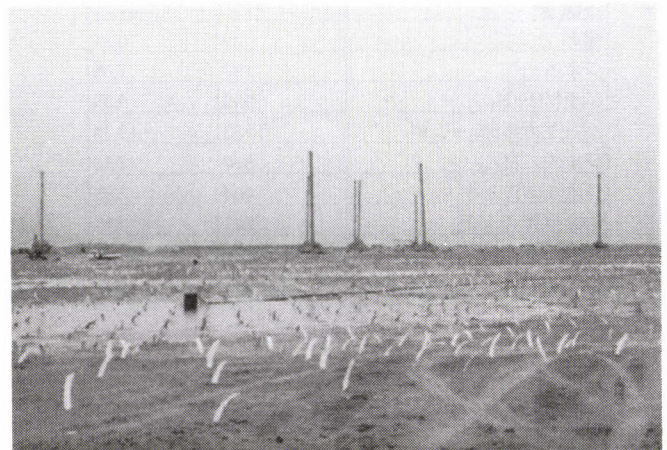
写真-3 プラスチックボードドレーン打設状況
