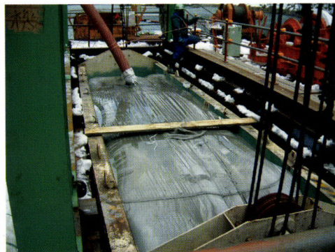
浚渫土注入終了
