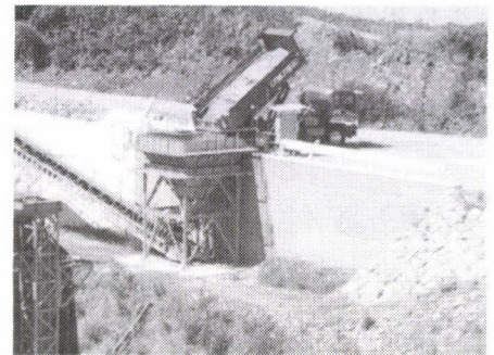
写真-3 施工中(骨材投入設備)
