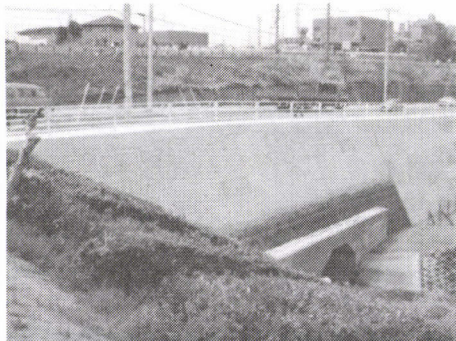
写真-8 完成後の供用状況
