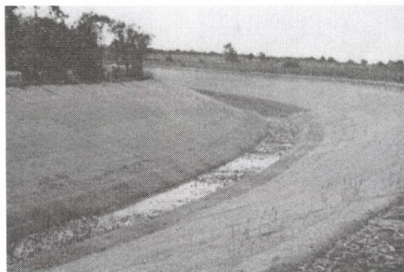
ヤシ繊維材料を用いた河川護岸
