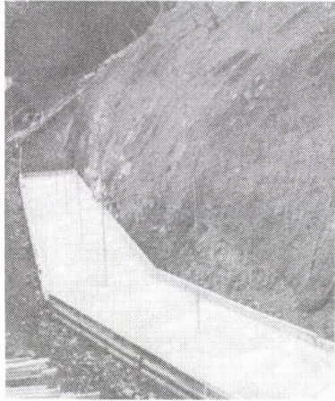
写真-1 下部反力版および緊張材
