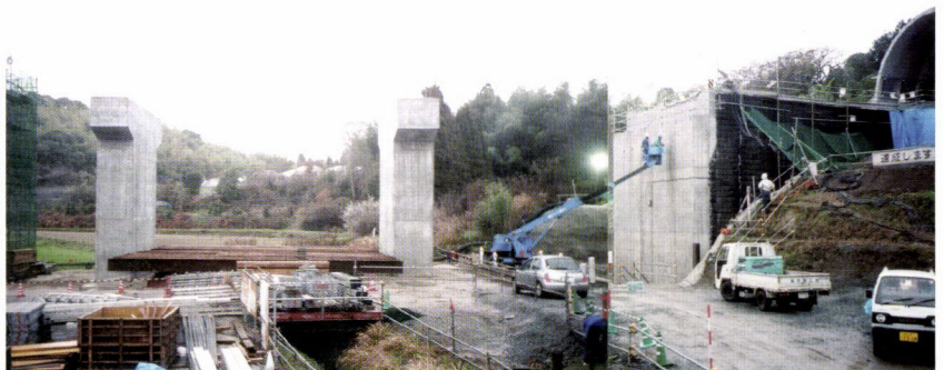
橋台完成状況
