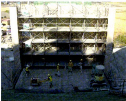
施工手順と施工状況
