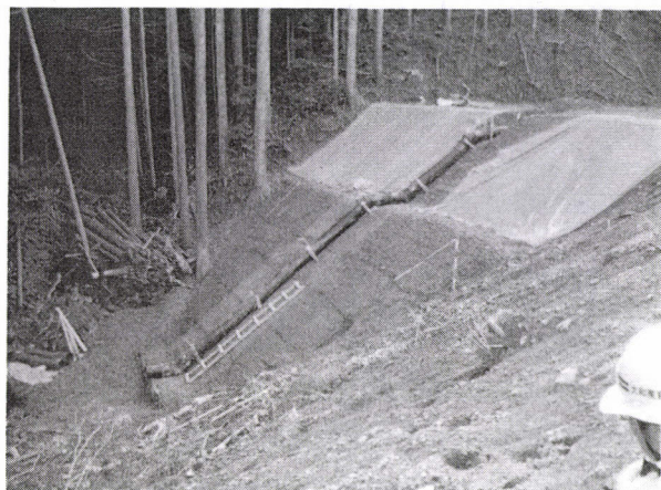
写真-1 補強不織布による緩勾配盛土の施工
