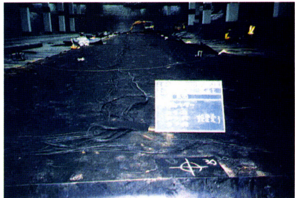
漏水検知システムの施工状況
