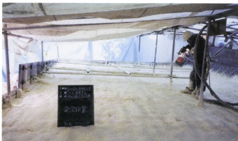
ウレタンの現場発泡作業 (アキレス株式会社)
