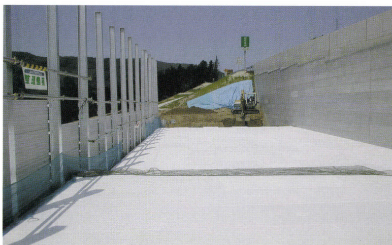
EPS道路拡幅盛土 (発泡スチロール土木工法開発機構)
