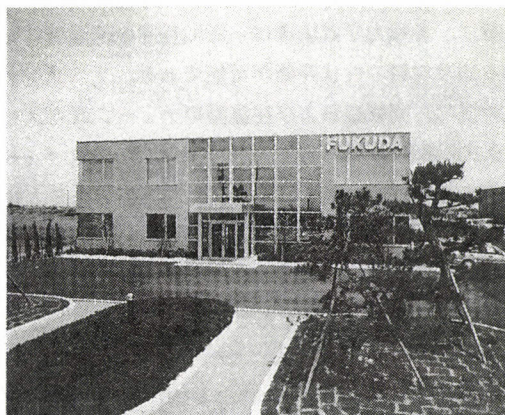
写真-1 福田道路(株)技術研究所
