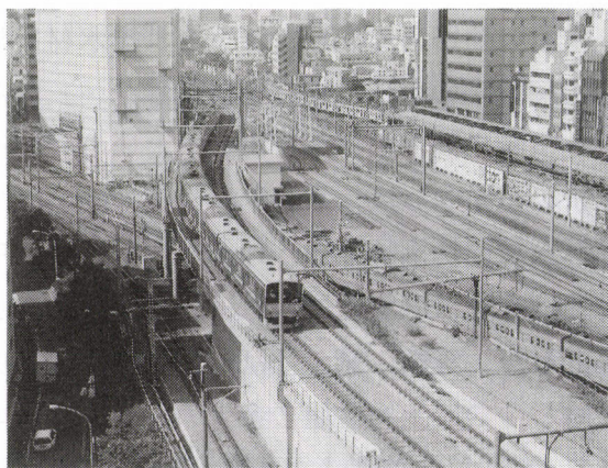
JR 山手線淀橋こ線線路橋全景
