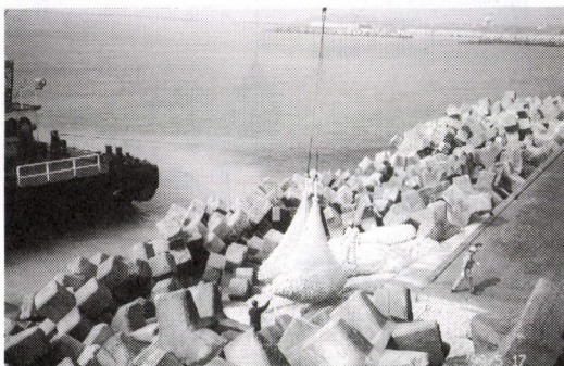
写真-6 コンクリートブロックの洗掘防止
