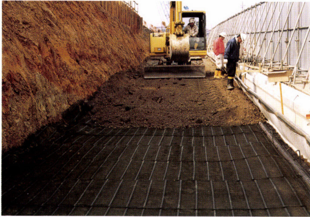
ジオグリッド敷設状況
