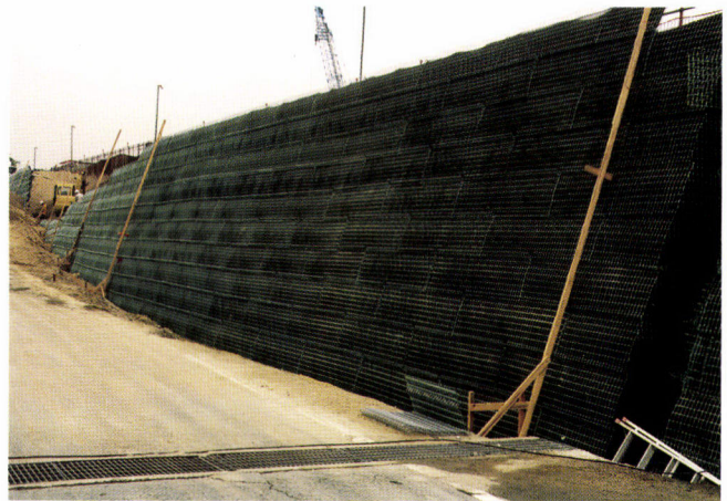
施工直後 (壁面材：鋼製型枠)
