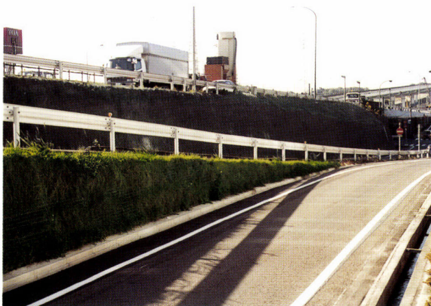
施工後 (供用6ヶ月後)
