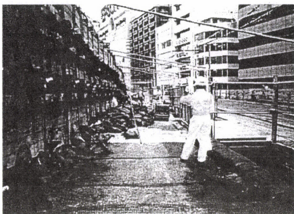
写真-2 新宿方施工状況
