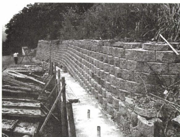
図-9 補強土擁壁Cの状況 (補強材の敷設間隔 60cm)
