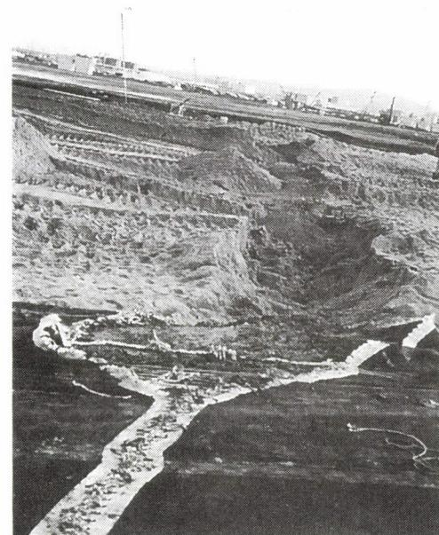
写真-1 シート・敷網工法におけるネット破断状況
