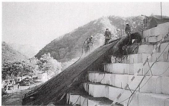
写真-1 連続繊維補強土の築造
