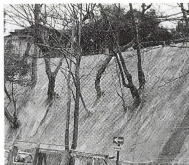
写真-4 連続纖維補強土の築造後
