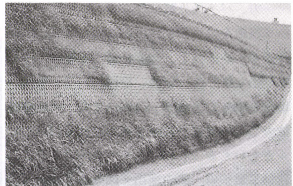
パワーグリッドの急勾配施工
