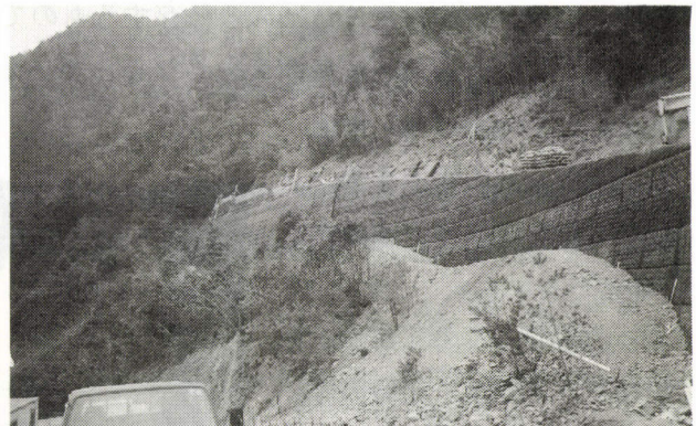
川辺川ダム取付け道路
