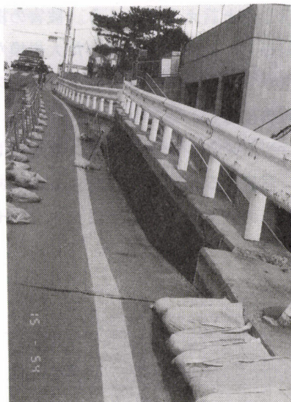
写真-2 山手幹線控え壁式擁壁
