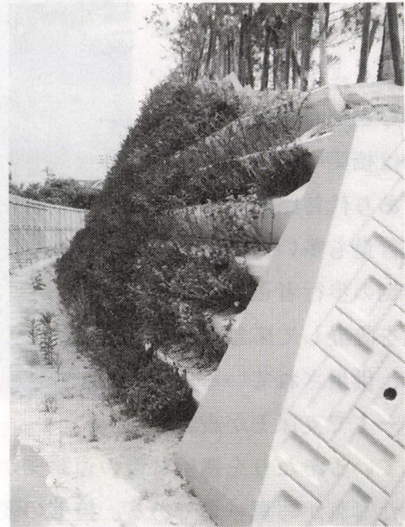
写真-5 ジオシンセティックで補強したブロック積擁壁
