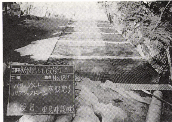
写真-5 水平排水材との複合施工状況
