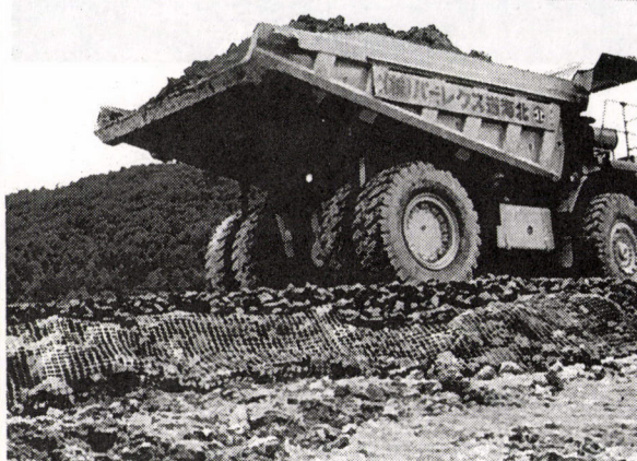
写真-9 補強完了後
