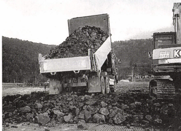
写真-8 補強状況
